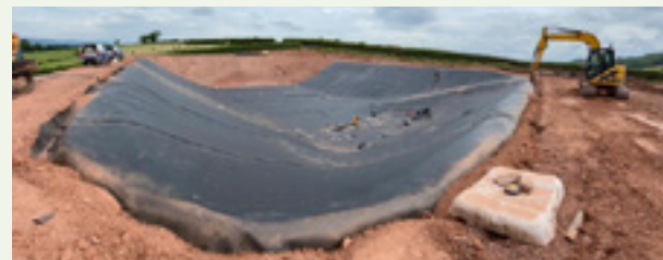
Ffigwr 4 – Gosod deunydd leinio lagŵn slyri newydd ar fferm Graig Olway
