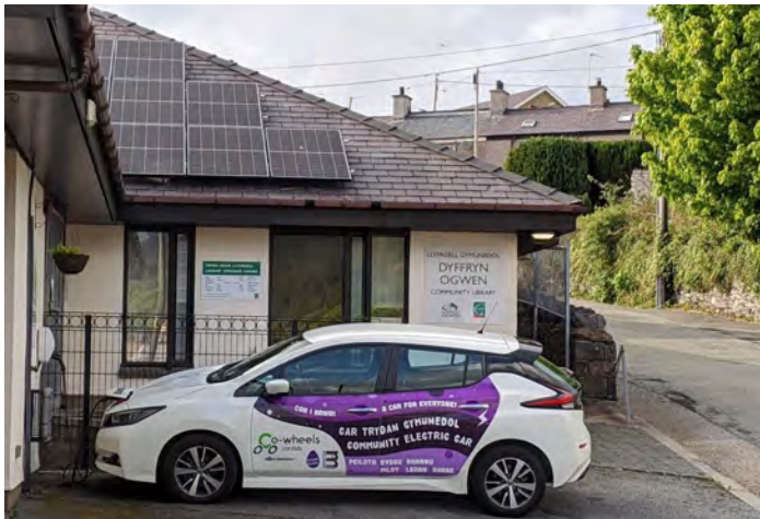
Paneli solar PV yn Llyfrgell Bethesda
